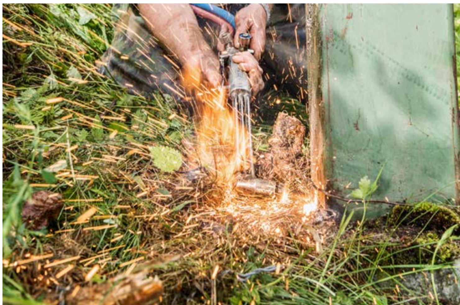
Attenzione! La sicurezza è d'obbligo, soprattutto quando si smontano i piloni metallici.
