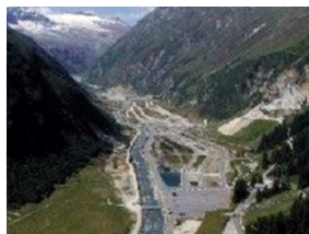
Place de tir de Hinterrhein
