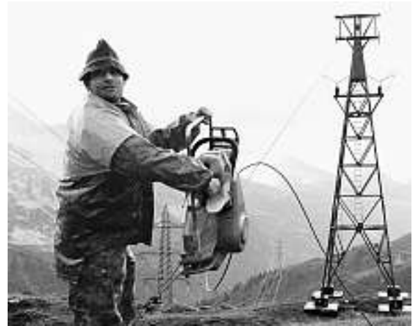
Mit einem Hi-Trac bringt Sdt Christian Graber den tonnenschweren Mast zu Fall.
