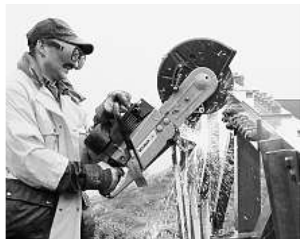
Arthur Venzin, Seilbahnspezialist der Luftwaffe, geht mit der benzinbetriebenen Trennscheibe zu Werk: Ziel sind lufttransportfähige Teile.
