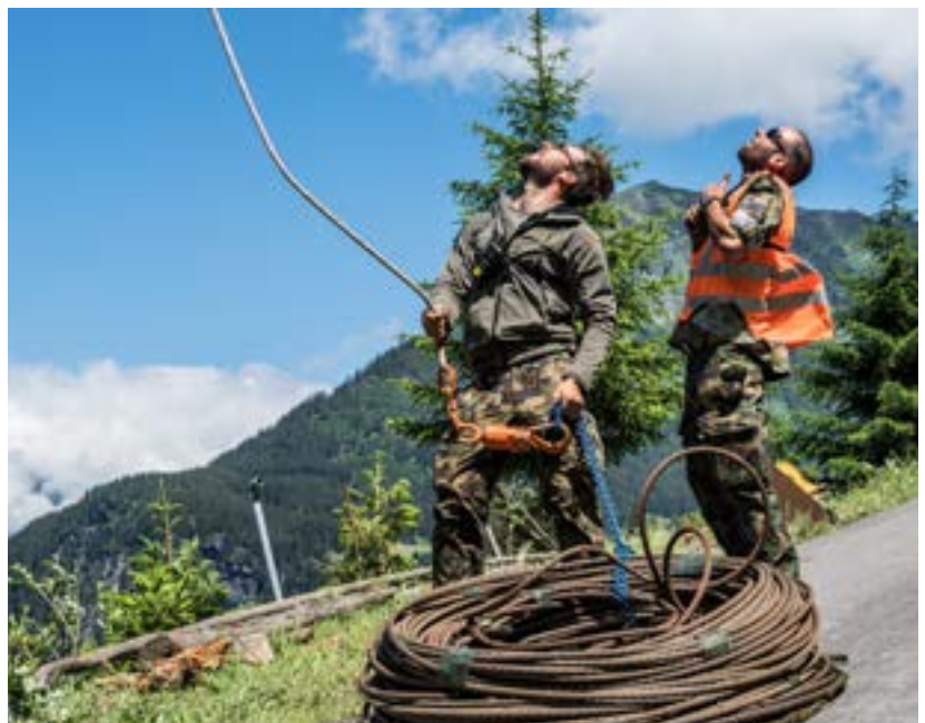
Die Drahtseile werden in mehrere Teile zerlegt, eingerollt und anschliessend wegtransportiert.
