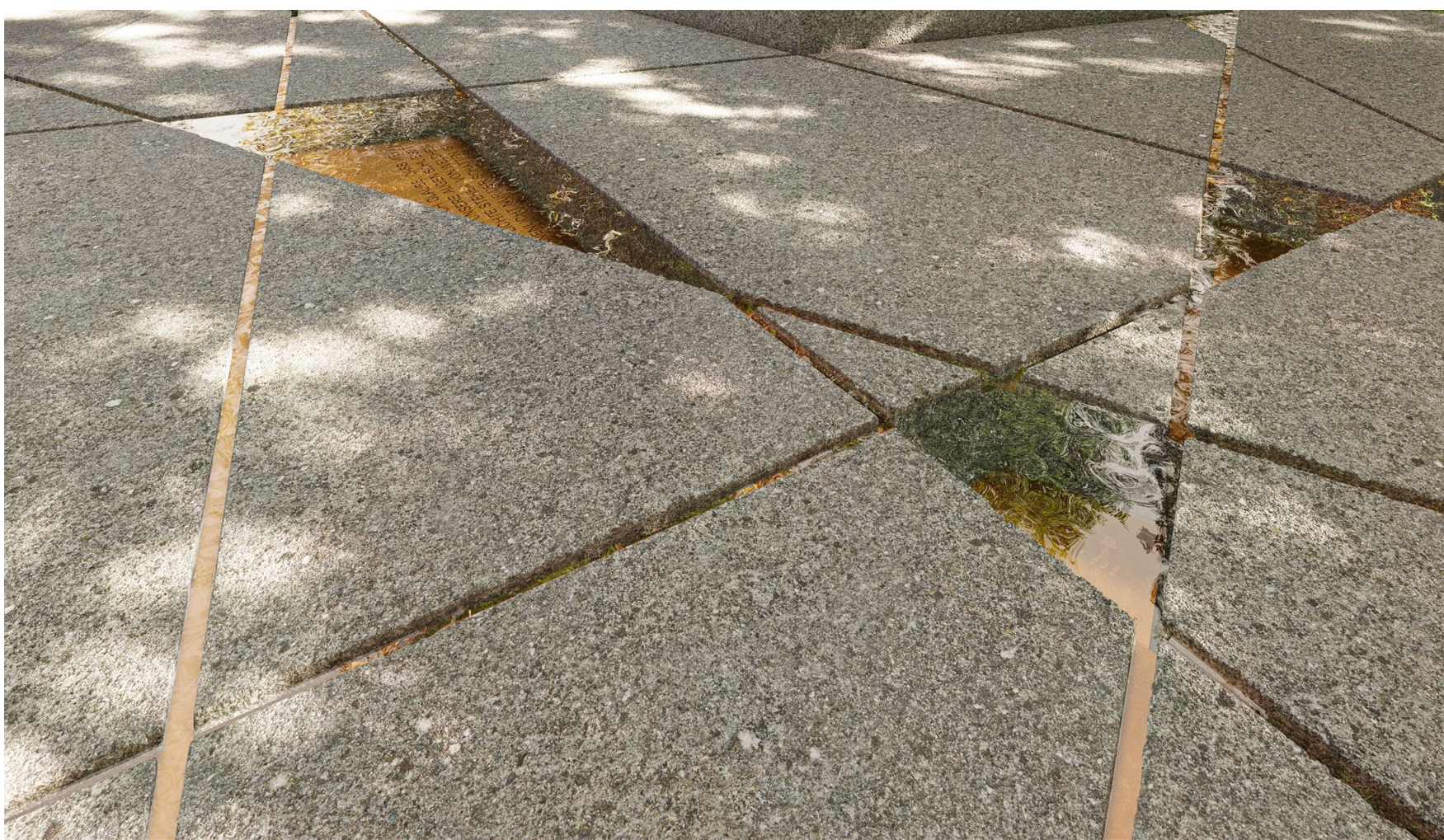
Steinerne Segmente, gegliedert durch zufällig fallende Linien. Die durch Stockung und Sandstrahlung subtil bearbeiteten Betonoberflächen brechen die strenge Erscheinung konventionellen Betons auf. Die Vielfalt und Farbigkeit der inneren Gesteins- und Kiesmischung treten an die Oberfläche.
