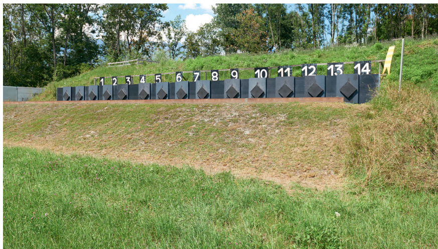
Fig. 39: Pre-parapalle in terra con piastra d'acciaio montata
