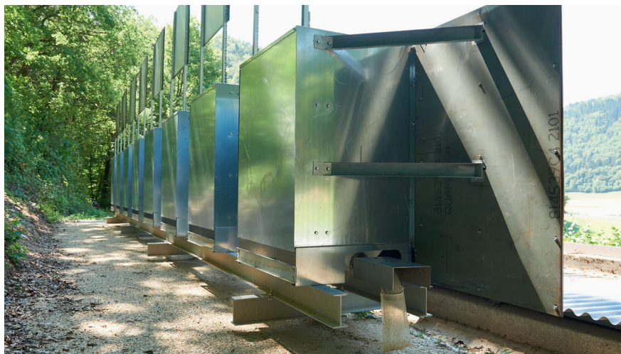
Fig. 50: Vista laterale del sistema di parapalle, variante Berin
