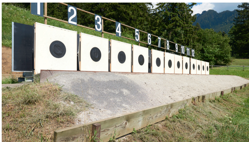
Fig. 40: Pre-parapalle in sabbia con piastra d'acciaio montata
