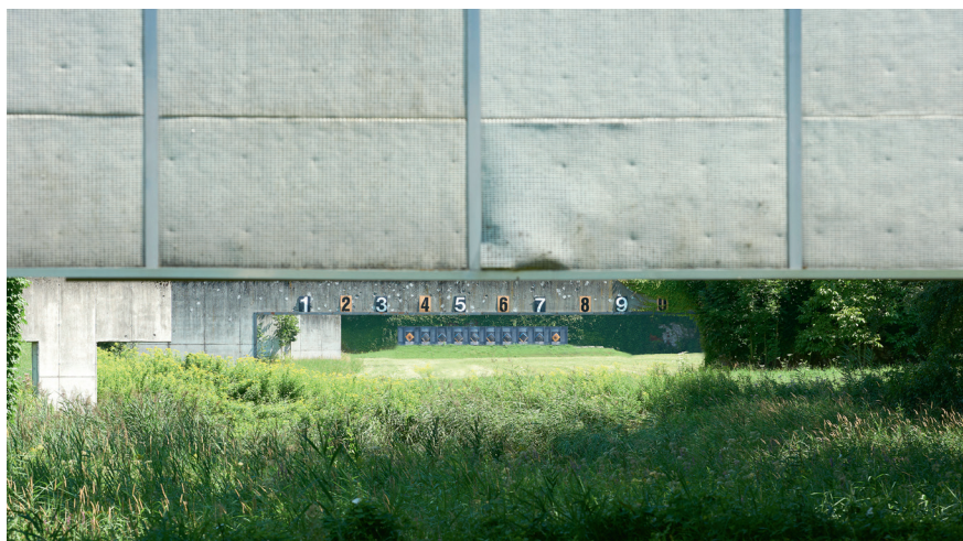
Fig. 57: Paratia laterale e d'altezza in cemento armato
