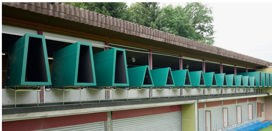
Fig. 23: Tunnel fonoassorbente (triangolare)
