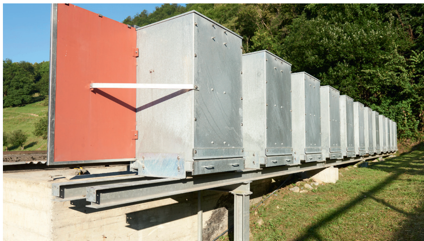
Fig. 48: Vista laterale del sistema di parapalle, variante L+H
