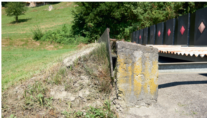
Fig. 38: Veduta della piastra d'acciaio montata
