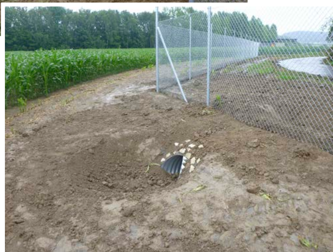
Les animaux peuvent traverser le terrain de la piste via les portails dans la clôture ou au moyen des tunnels prévus à cet effet. En cas de nécessité, le personnel de la Base peut les fermer et rendre le périmètre totalement imperméable aux intrusions, le temps d'une mission par exemple.
