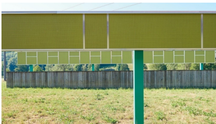
Abbildung 61: Betontiefblende und 2 Hochblenden, Nahblendenkonstruktion
