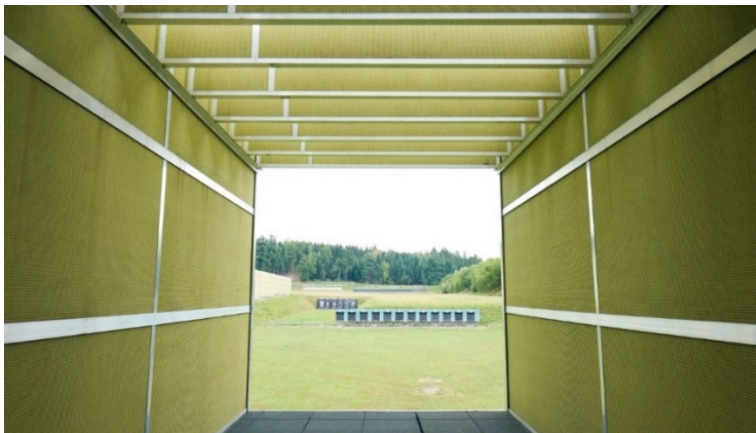
Abbildung 21: Schallschutzwand, mit Fächer oben
