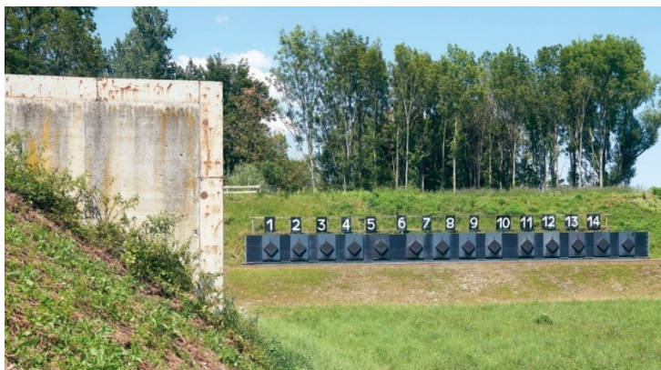
Abbildung 57: Betonseitenblende
