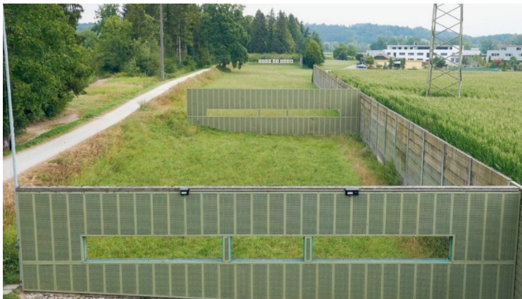
Abbildung 58: Betontief- und Betonhochblende
