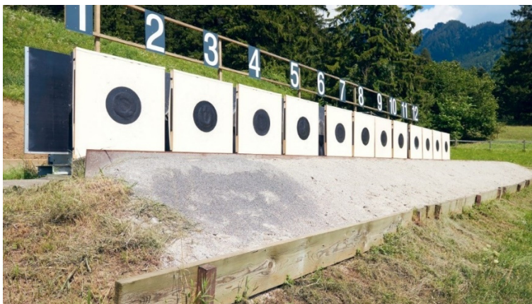
Abbildung 38: Vorkugelfang, Sand mit montierter Prellplatte
