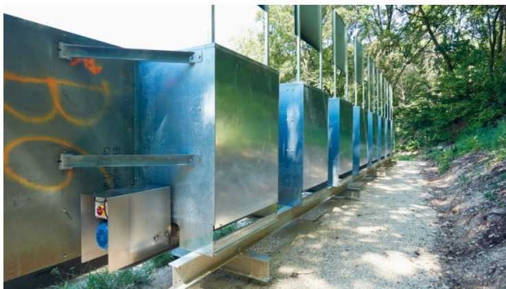
Abbildung 72: Kugelfangsystem von hinten, Berin mit Austragungssystem
