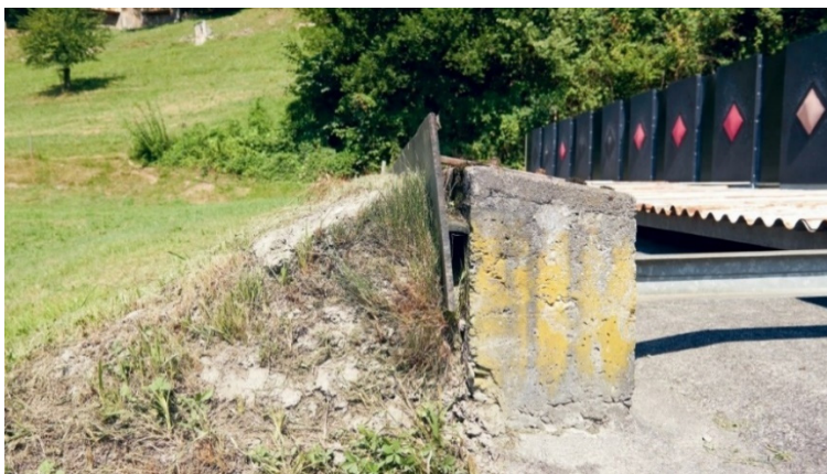
Abbildung 36: Ansicht der montierten Prellplatte
