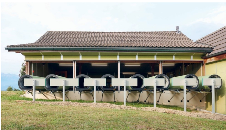
Abbildung 63: Seitenblende, Nahabblendenkonstruktion mit Tunnel (Sicht von aussen)
