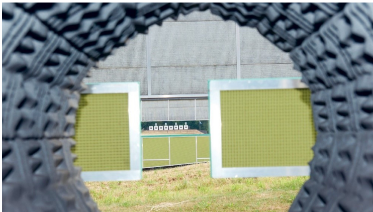
Abbildung 62: Seitenblende, Nahabblendenkonstruktion mit Tunnel (Sicht der Schiessenden)
