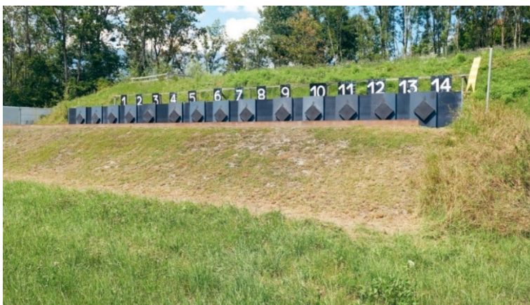
Abbildung 37: Vorkugelfang, Erde mit montierter Prellplatte
