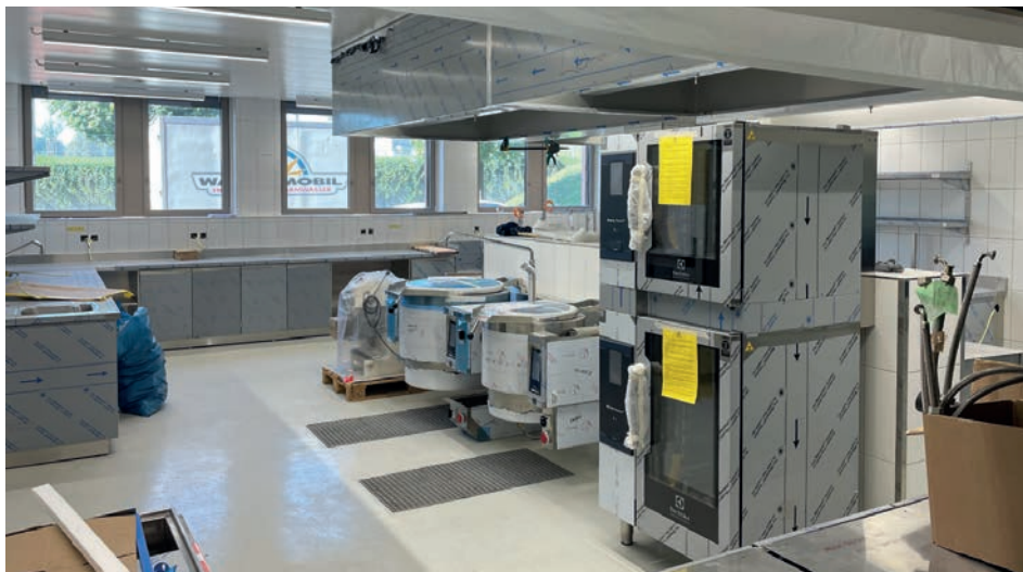
Hier entsteht eine zeitgemässe Küche (Oktober 2023)
