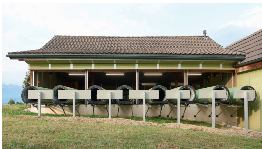
Abb. 64: Seitenblende Nahblendenkonstruktion mit Tunnel (Sicht von aussen)
