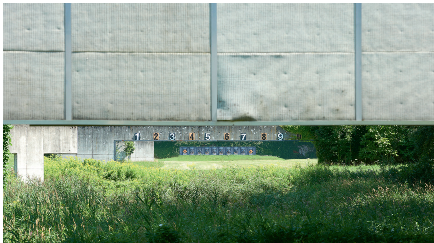
Abb. 57: Betonhoch- und Betonseitenblende
