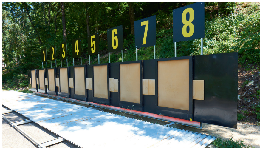
Abb. 47: Kugelfangsystem Frontansicht Variante Berin
