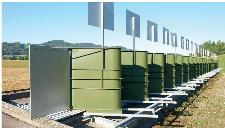
Abb. 49: Kugelfangsystem Seitenansicht MaRep
