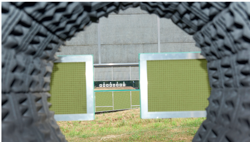
Abb. 63: Seitenblende Nahblendenkonstruktion mit Tunnel (Sicht des Schützen)
