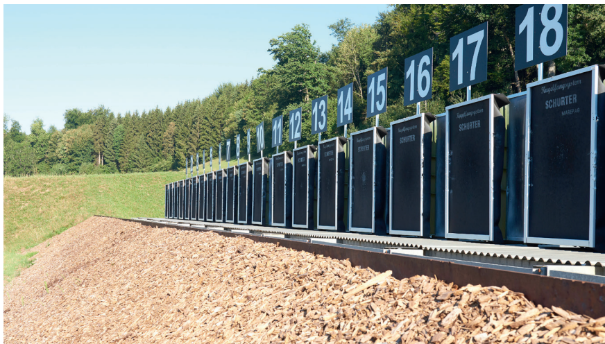
Abb. 46: Kugelfangsystem Frontansicht Variante MaRep
