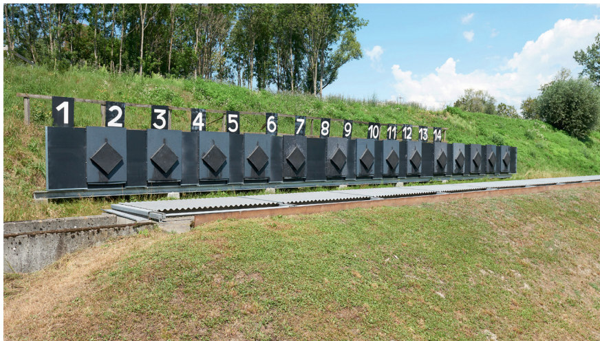
Abb. 45: Kugelfangsystem Frontansicht Variante L+H
