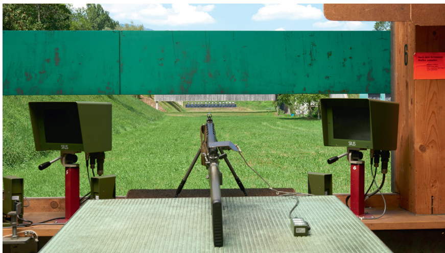
Abb. 60: Hochblende Nahblendenkonstruktion
