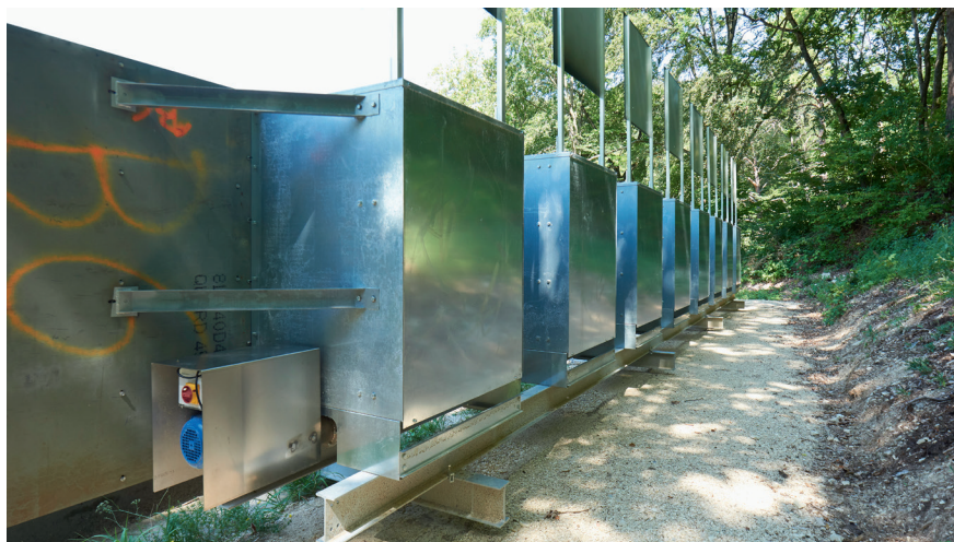
Abb. 53: Kugelfangsystem von hinten Berin mit Austragungssystem
