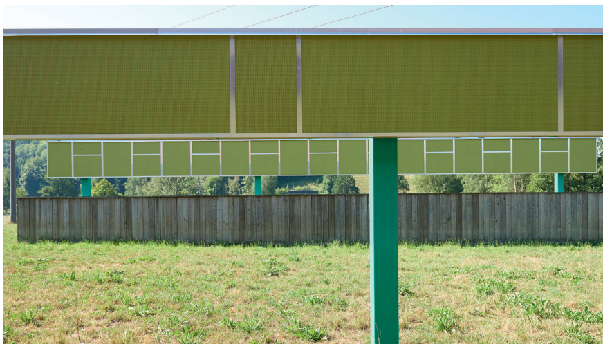
Abb. 62: Betontiefblende und 2 Hochblenden Nahblendenkonstruktion
