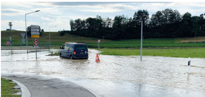
Abb 5: 2020, Überschwemmungen Kreiselpunkt Rüeggingerstrasse/Seetalstrasse
