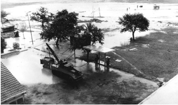
Abb 1: 1956, Überschwemmungen im Bereich Flugzeughalle 1/Garage
