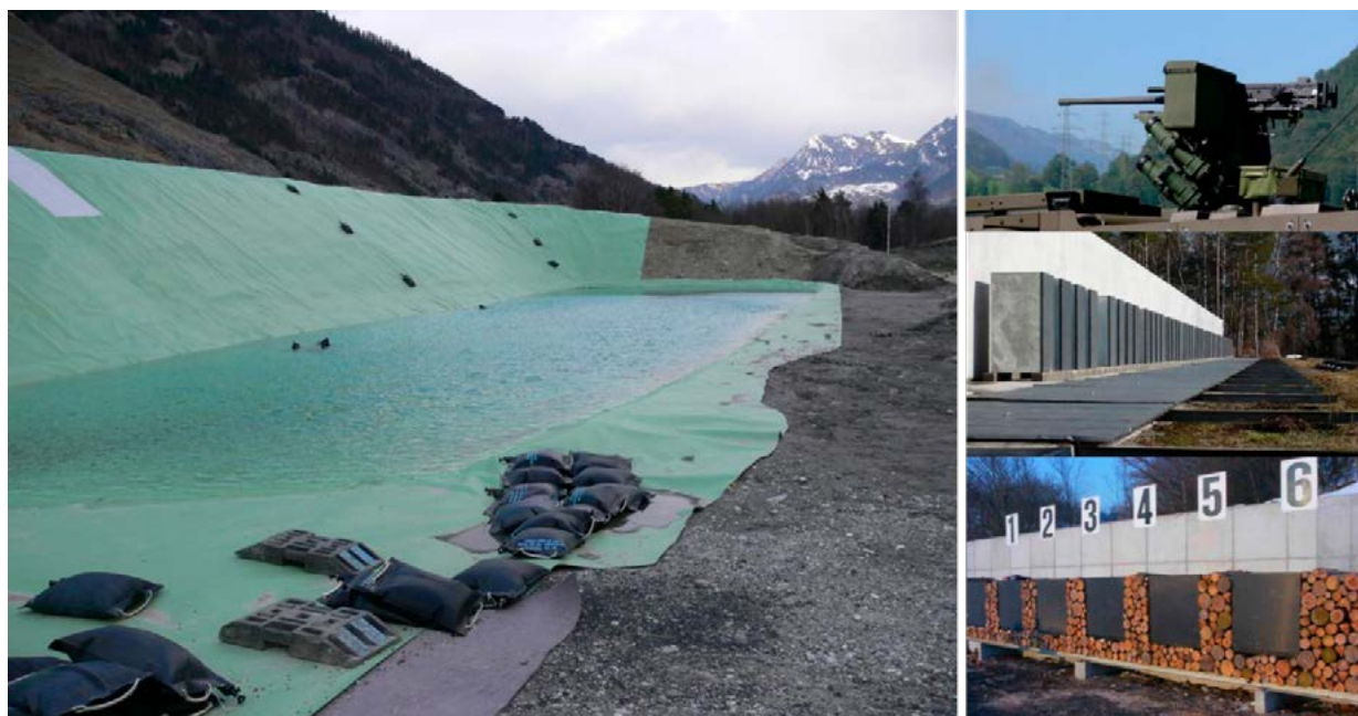
Figure 4 : Installation de systèmes pare-balles sur la place de Rossboden, Coire (avec autorisation d'armasuisse Immobilier)
