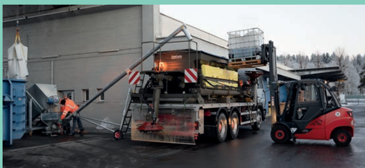
Auffüllen von Granulat (li) und Flüssigkeit (re). Am LKW gelb: Tank für Flüssigkeit
