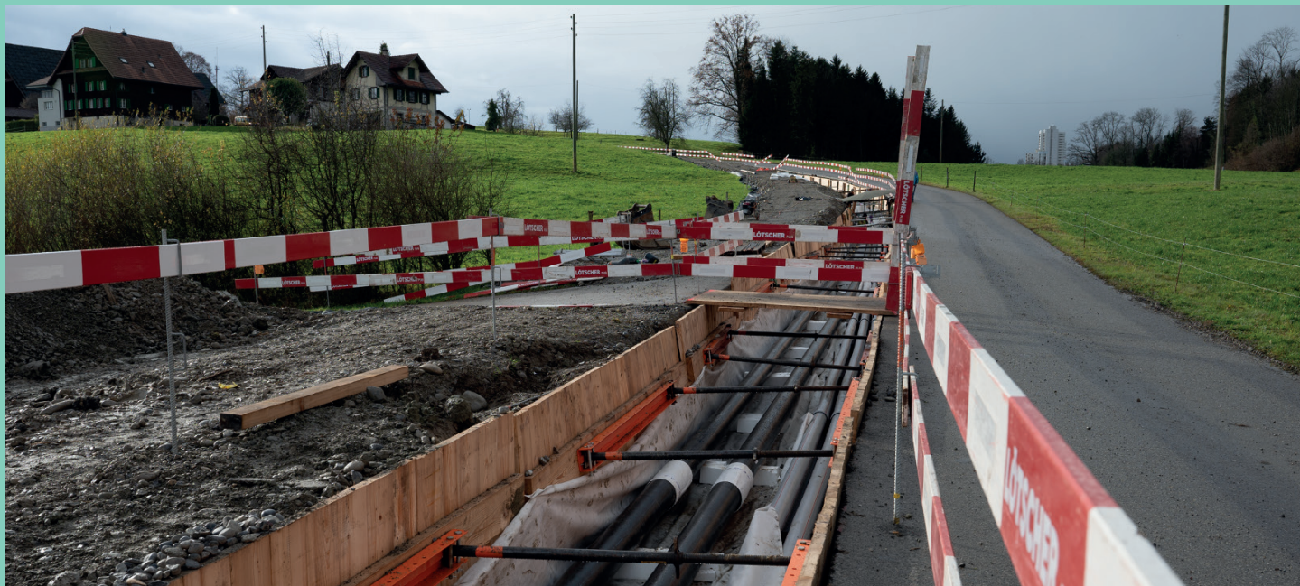
Die Fernwärme-Leitungen und Elektrorohre werden an der Oberhülsenstrasse in Emmen verlegt.
