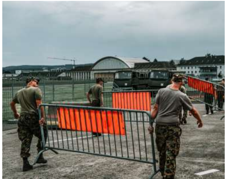
Bild 2: Erstellen von Absperrungen
