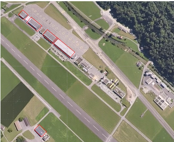
Foto: Photovoltaikanlagen auf dem Militärflugplatz Alpnach
