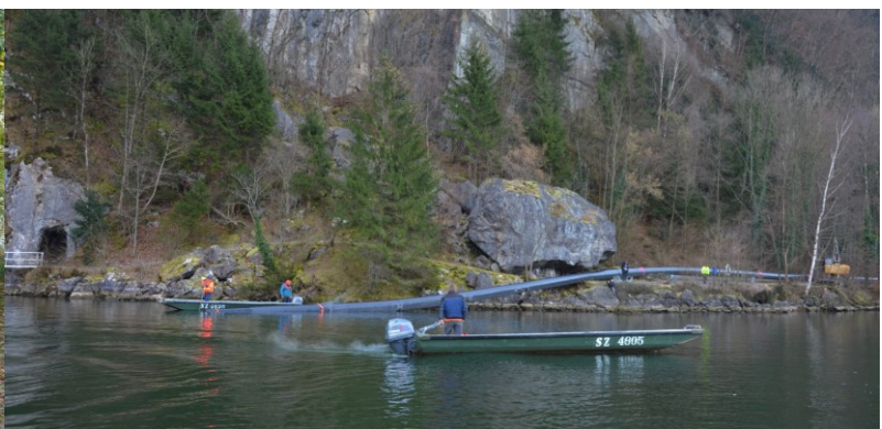
Wassern der Rohrleitung
