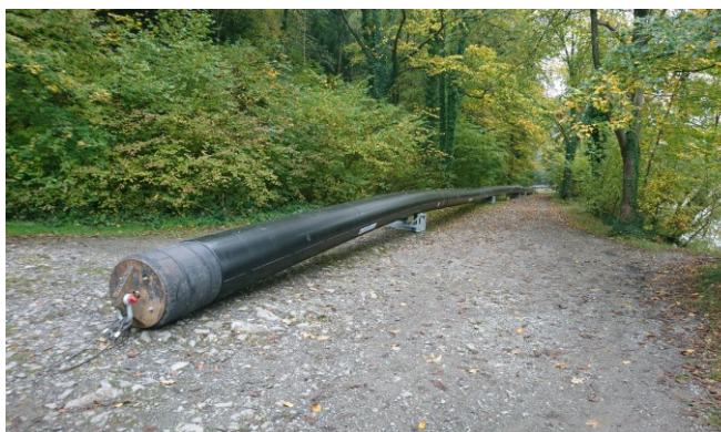
Fertig gestelltes Kunststoffrohr
