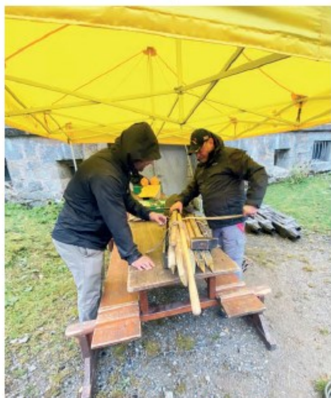
Bei Wind und eisigen Temperaturen wurden am Freitag die Lasten vorbereitet.
