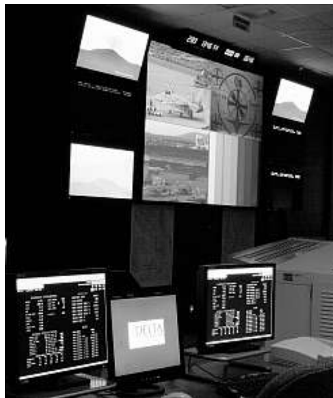
Le centre de contrôle du site d'essai de China Lake.
