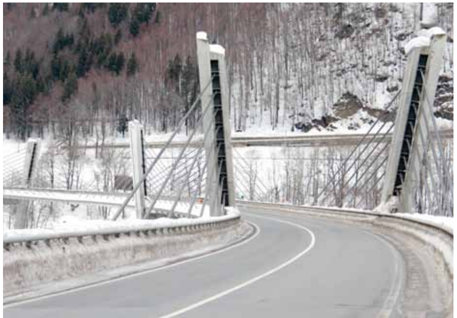
Das ausgezeichnete Bauwerk: die Sunnibergbrücke.
