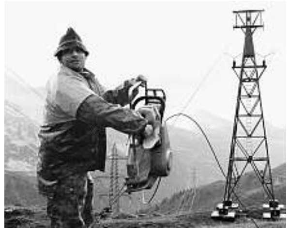
Mit einem Hi-Trac bringt Sdt Christian Graber den tonnenschweren Mast zu Fall.
