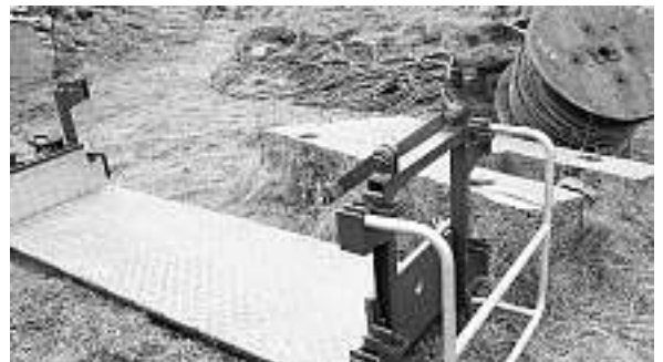
Einzelteile der ehemaligen Seilbahn im Val d'Ogia liegen bei der Mittelstation zum Abtransport bereit.
